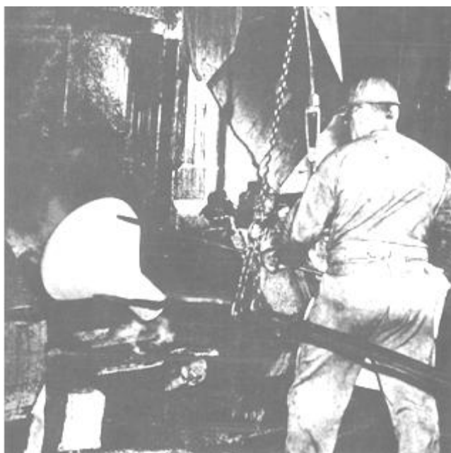
شکل ۱۱. فورج شفت توربین سوپرآلیاژ پایه آهن- نیکل A-۲۸۶
